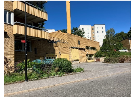
Befintlig sopsugstation och värmecentral inom Stapelbädden 8.
